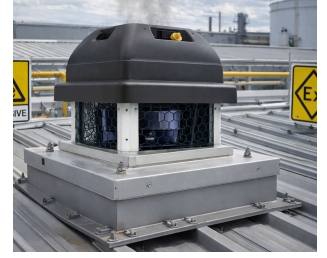
ÇATI MONTAJI UYGULAMASI
